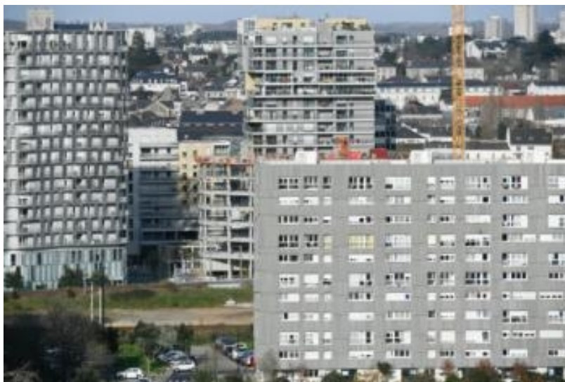
Des logements HLM dans le quartier Malakoff de Nantes.
